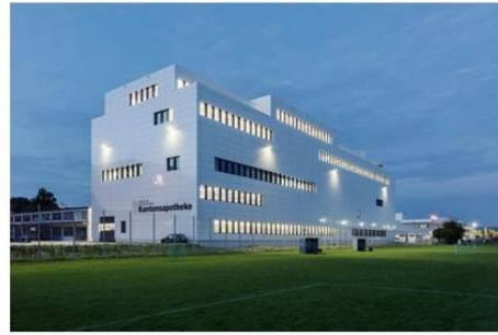
Verwaltungs-, Herstell- und Logistikgebäude der Kantonssapotheke in Schlieren
